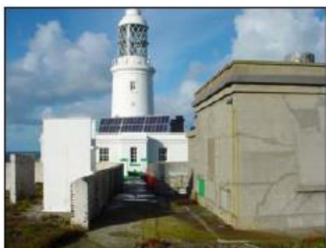
Малюнок 8: Приклад різних категорій стану: експлуатований маяк пофарбований, тоді як неексплуатований резервний машинний зал на передньому плані залишено нефарбованим (о-в Раунд-Айленд, об'єкт 31 ТН на малюнку 9).
