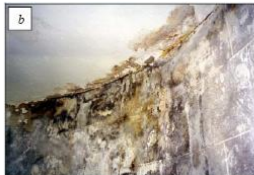
Малюнок 31: (a) Погіршення стану та руйнування штукатурки, пов'язані з утворенням вицвітів сульфатних солей; (b) плями на стінах у верхній секції башти Св. Петра, зумовлені поєднанням цвілевого грибка та корозії зі службового приміщення, розташованого вище, спричинених проникненням вологи унаслідок частих затоплень галереї ліхтаря.
