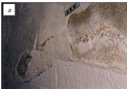
Малюнок 31: (a) Погіршення стану та руйнування штукатурки, пов'язані з утворенням вицвітів сульфатних солей; (b) плями на стінах у верхній секції башти Св. Петра, зумовлені поєднанням цвілевого грибка та корозії зі службового приміщення, розташованого вище, спричинених проникненням вологи унаслідок частих затоплень галереї ліхтаря.
