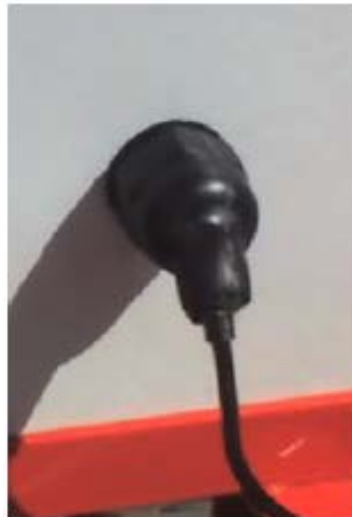
Малюнок 19 Герметизований кабельний ввід з термоусадковою трубкою
