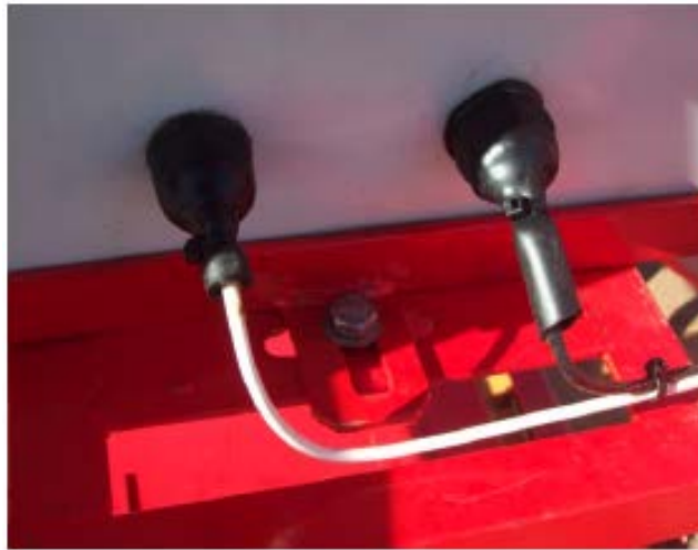
Малюнок 18 Герметизація антени та елементів живлення
