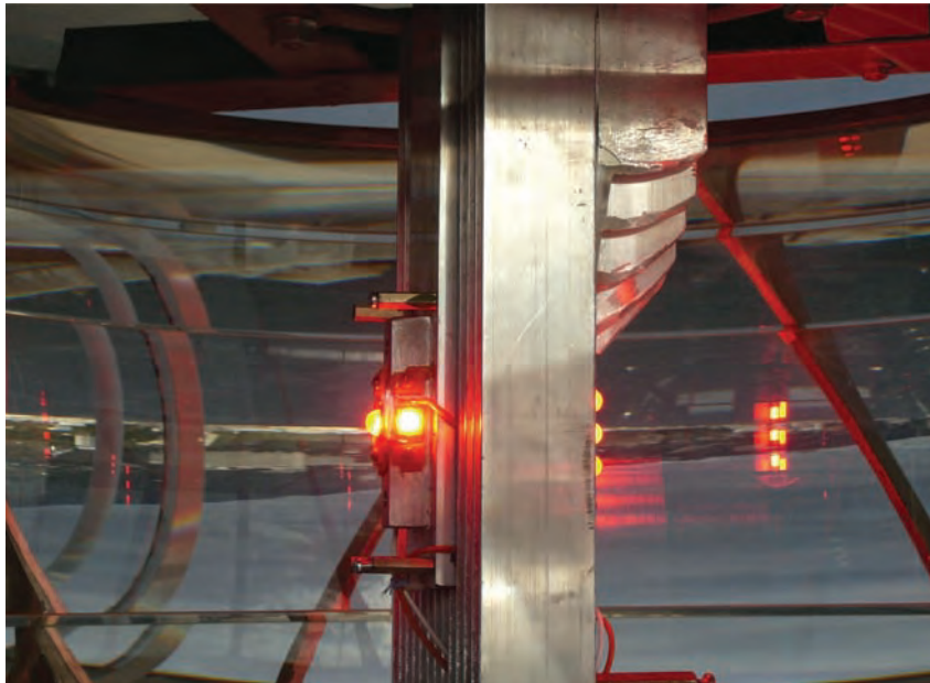
Світлооптичний апарат на світлодіодних модулях, установлений на Ялтинському маяку
