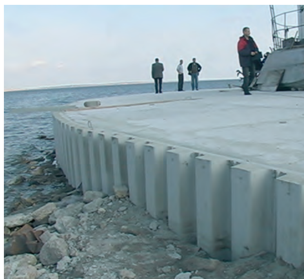
...і кінець спорудження бетонного кільця навколо башти Адзигольського маяка Переднього
