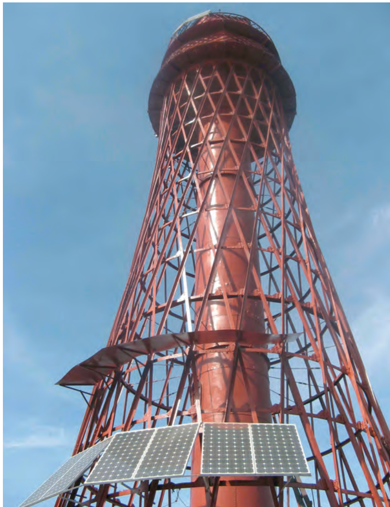
Такого вигляду набула металоконструкція після ремонту
