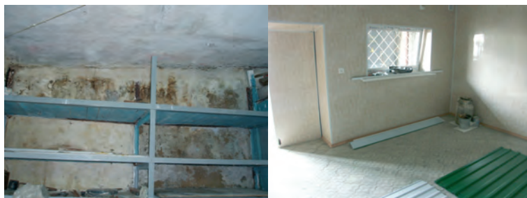
Приміщення майстерні до ...та після ремонту
