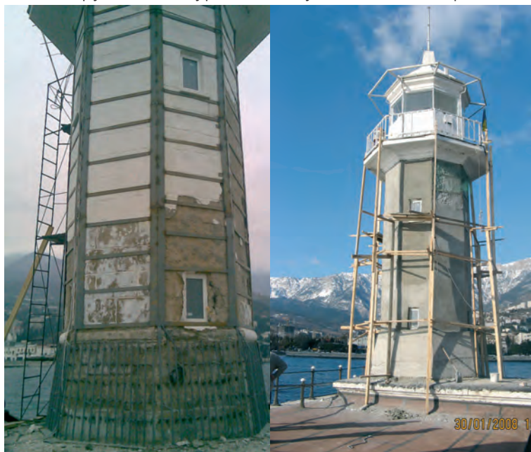
Риштування навколо стовбура башти
