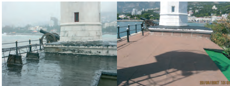
Покрівля службових приміщень до ...та після ремонту
