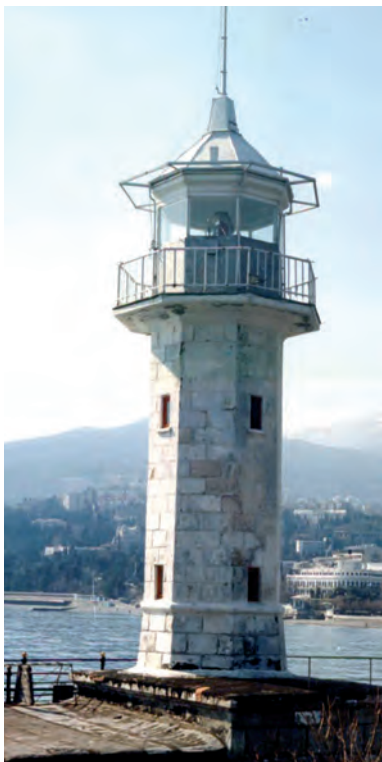
Такий вигляд мала башта до ремонту
