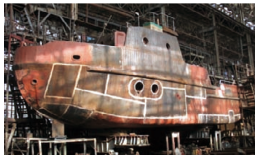
Під час ремонту корпусу судна
