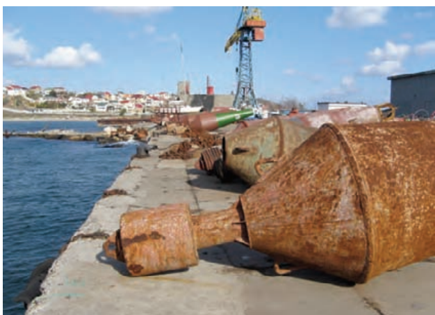
Причал РВБ Іллічівському порту – до ремонту
