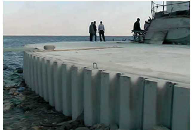
і... після ремонту
