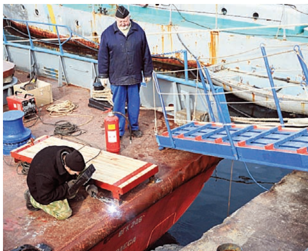
Встановлення обладнання для скидання якорів
