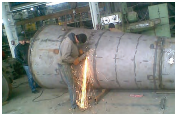
Зачищення зварного шву
